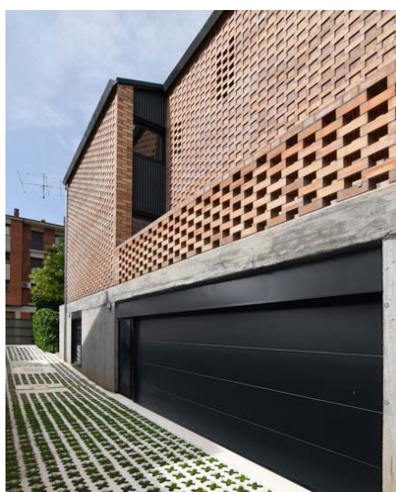
▲ MENCIÓN "MEDIOAMBIENTE" a la vivienda unifamiliar en CV/ Virgen del Plano 12 en Barbastro (Huesca), realizada por Grupo Gen Arquitectura y Sergio Latre Palacio.
