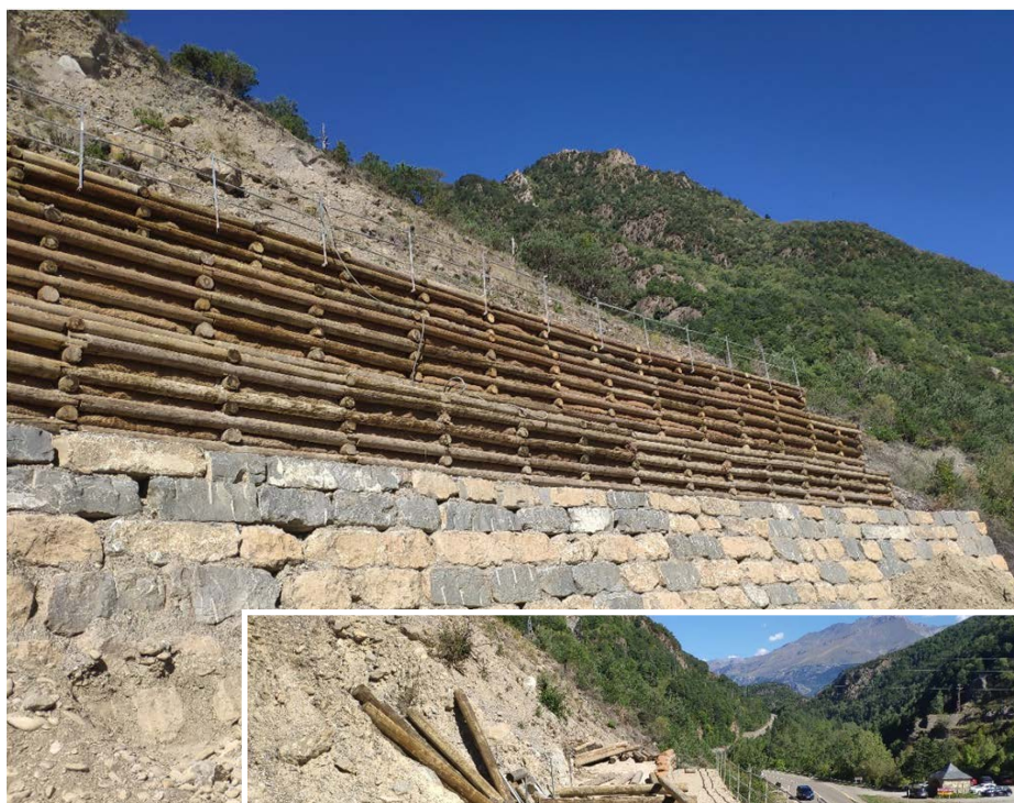
Control de erosión hídrica superficial y desprendimientos de bloques en el talud en la carretera A-136, en las proximidades del fuerte de Santa Elena (Biescas), mediante estructuras de madera.
