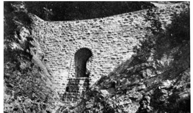
Foto 4. Dique "vacío" diseñado por Ayerbe para retención de aludes en el torrente Epifanio.
